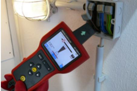
Rastree cables con o sin tensión retirando la cubierta de la caja de conexiones.
